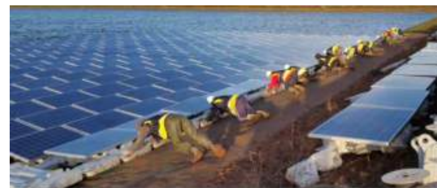
Mise à l'eau de flotteurs (source Ciel&Terre)
