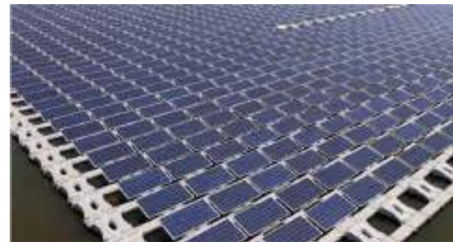
Exemple de flotteurs avec panneaux solaires (source AKUO)
