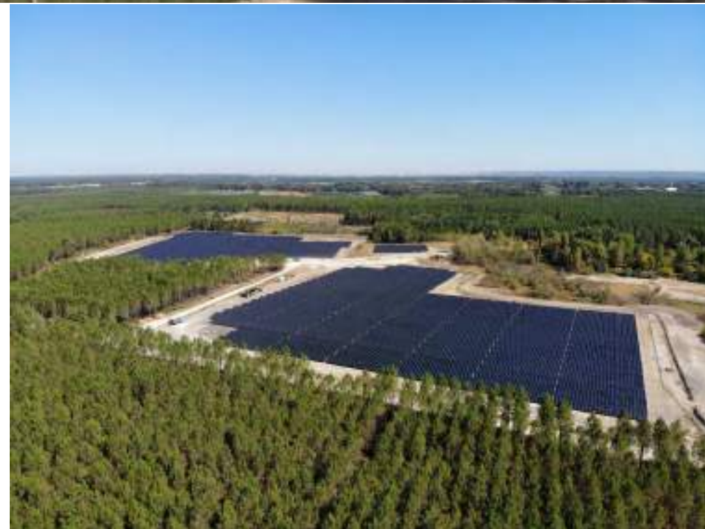
Parc solaire « La Brède », construit dans la commune de La Brède
