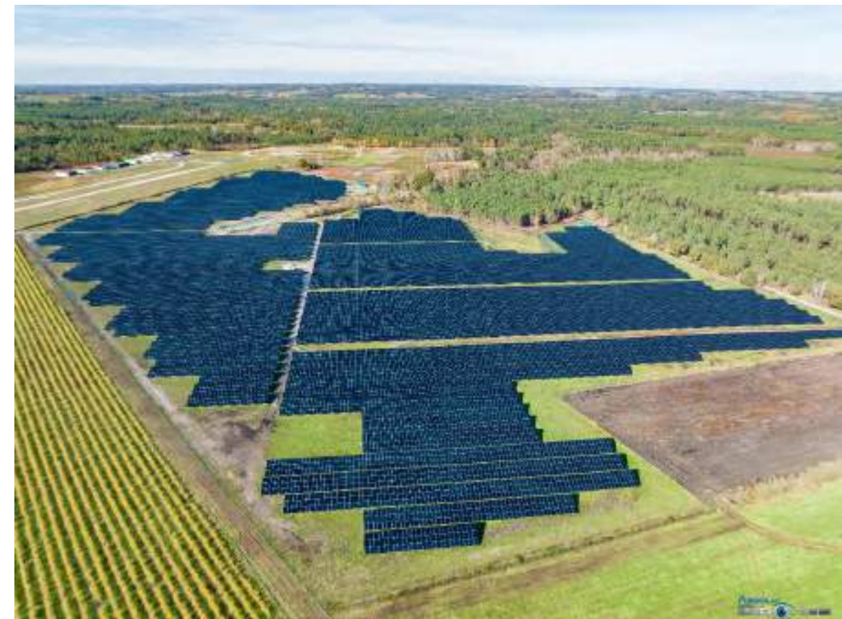
Parc solaire « Sablé Rouge », construit dans la commune de Val de Livenne
